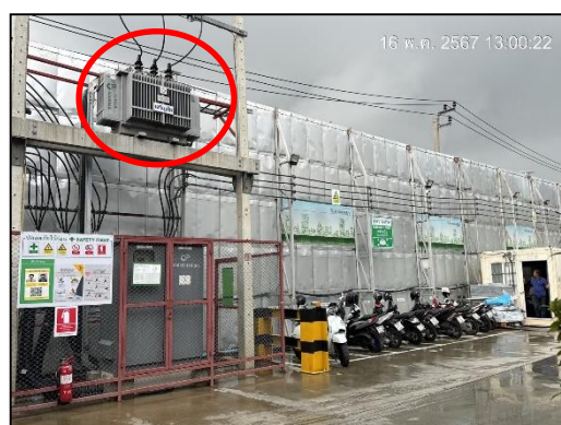
ภาพที่ 41 หม้อแปลงไฟฟ้า
