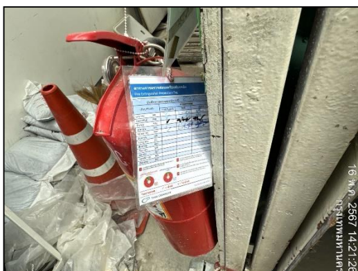
ภาพที่ 72 ตรวจสอบเช็คสภาพถังดับเพลิง
